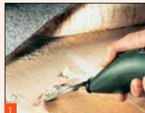
1 Na menších plochách a při jemnější práci v rozích se nabízí elektrická škrabka, do níž se mohou nasadit různé čepele.
